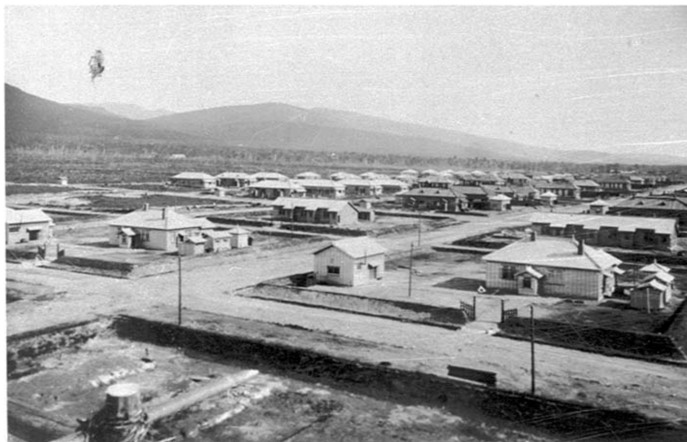
写真2 1908年ころの官舎街 [株式会社伊藤組土建所蔵]
